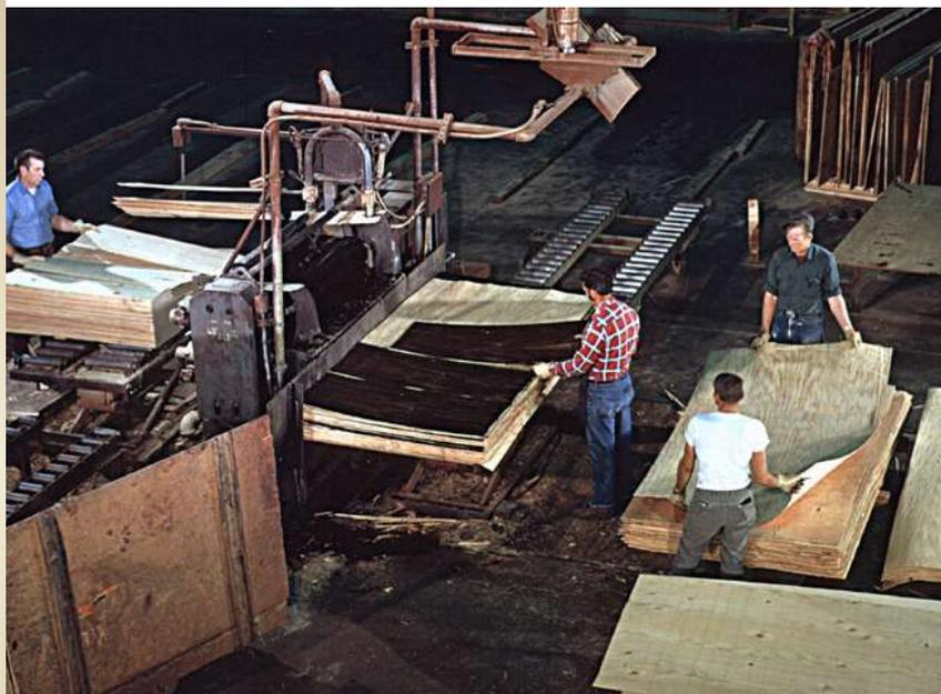
El adhesivo se aplica en las dos caras internas de la chapa (listones cruzados) para colocar las chapas o fibras en capas.
