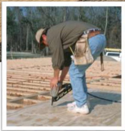
Una de los usos más comunes para los Paneles , son los pisos o material de cubierta. En caso de que se muevan cargas pesadas sobre los paneles, como en los paneles de los entrepisos, es necesario considerar paneles con superficies mejoradas.
