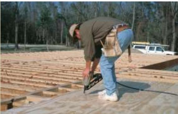
Las clasificaciones típicas podrían ser: A-B, A-C, B-C y Bajo Piso (diseñado para proporcionar una superficie de subsuelo suave para pisos delgados).
